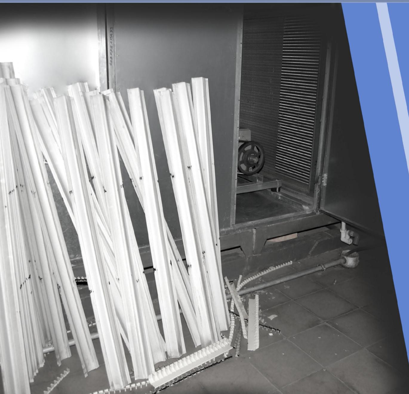
Разобранный каплеуловитель вынут. Лопасти и крепления непригодны для ремонта и дальнейшего использования. В данном случае персонал, обслуживающий установку, во время демонтировал пришедшую в негодность конструкцию.
